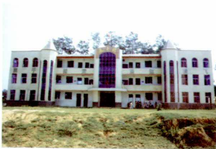
逸夫小学 大楼—逸夫楼
