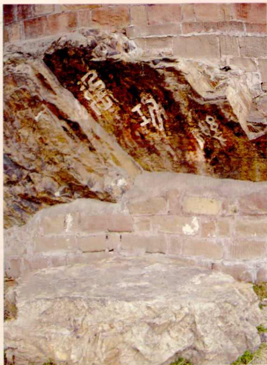
晴川阁主楼之下的禹功矶（局部）
