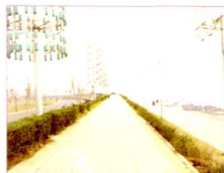
1999年竣工的 南岸嘴驳岸堤坝顶
