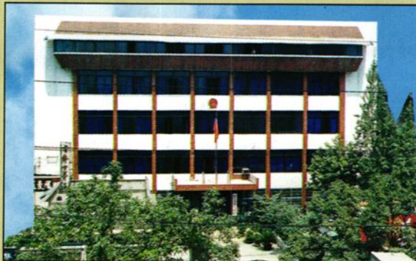
▼ 1953年修建,80年代扩建加层的第一办公楼。
