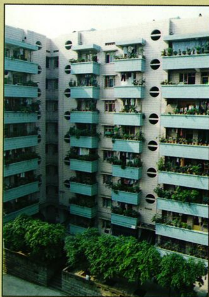
▲ 1993年修建的干警住宅楼。
