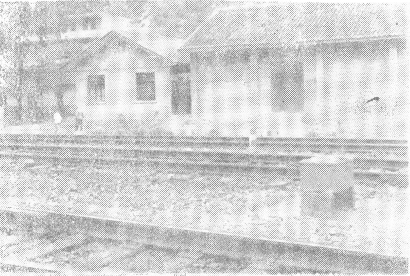
转运站位于成昆铁路线上，距桥盐（火车）发运地峨眉124公里。
