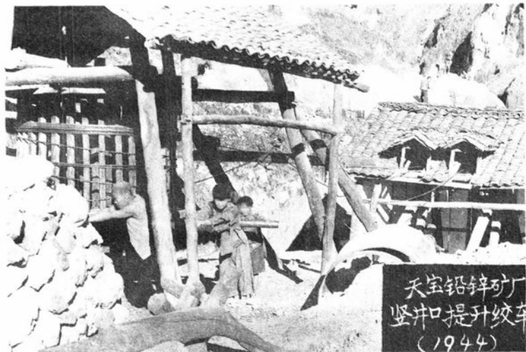
天宝铅锌矿厂竖井口提升绞车(1944)
