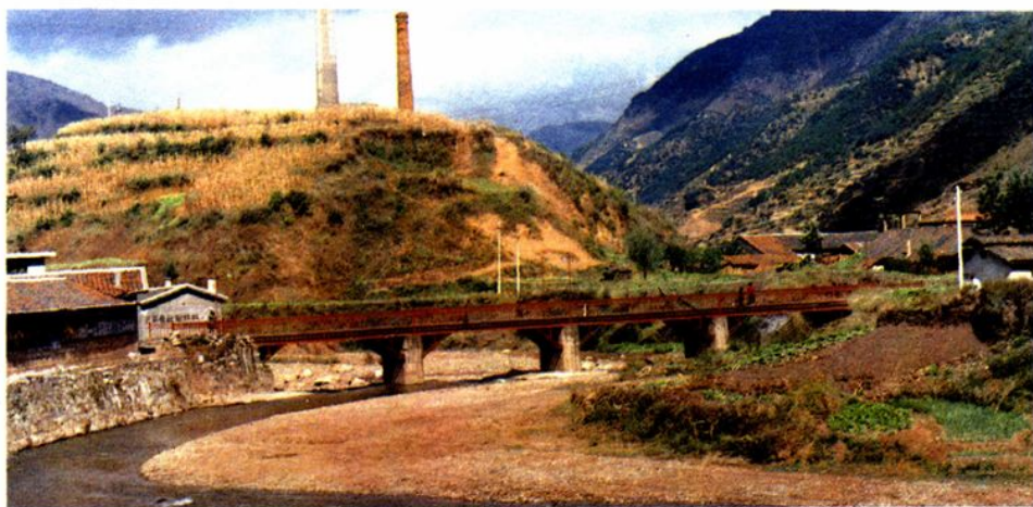
益门矿区自建公路铁桥(1982)
