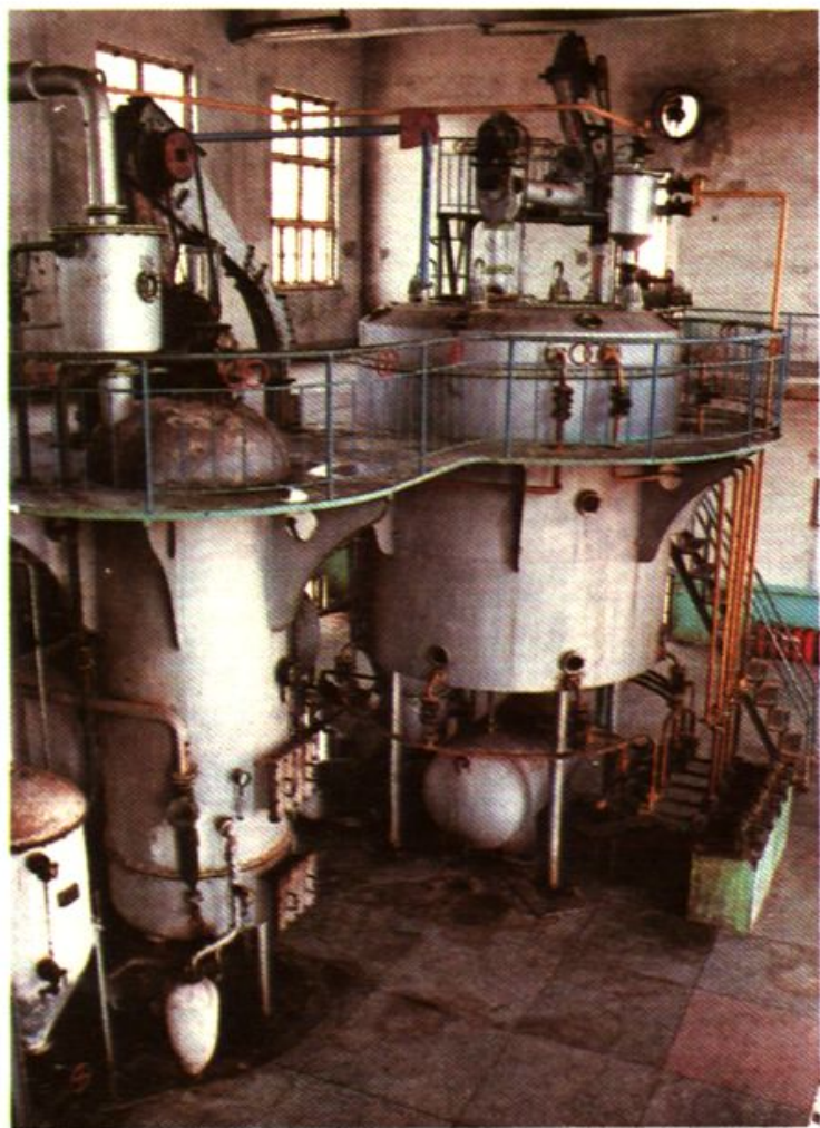
青县植物油厂浸出车间
