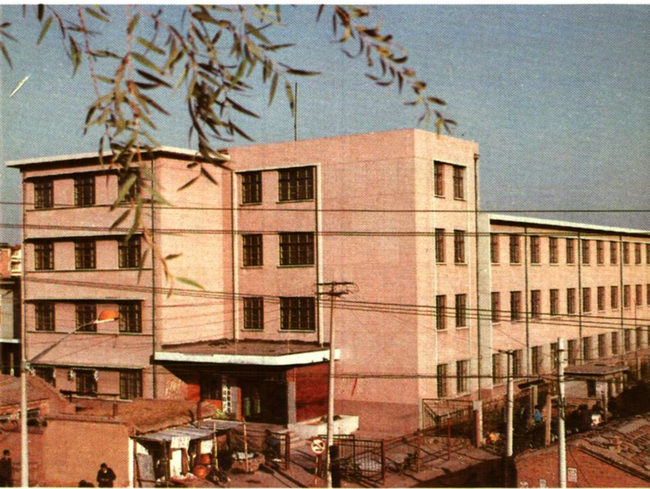
沧州市粮食局办公楼(1986年3月,局机关迁入此楼办公)
