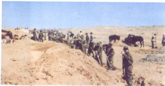
驻高台部队为民修渠
