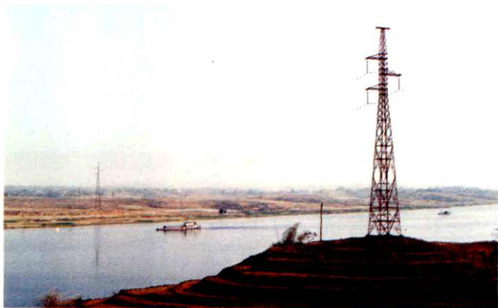
< 1964年建成的西津至南宁 220 千伏送电线路跨郁江段
