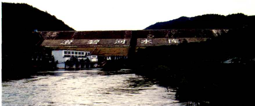
▷ 1966年发电的澄碧河 水利水电枢纽(装机2.6万 千瓦)
