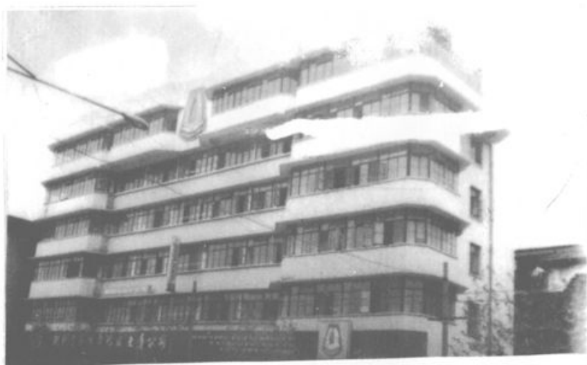
衡阳市棉麻土产公司经营大楼 ↑
