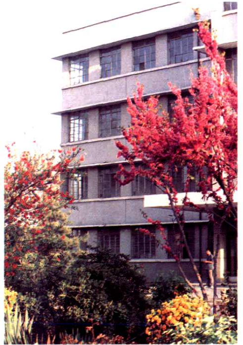
实验大楼一角
