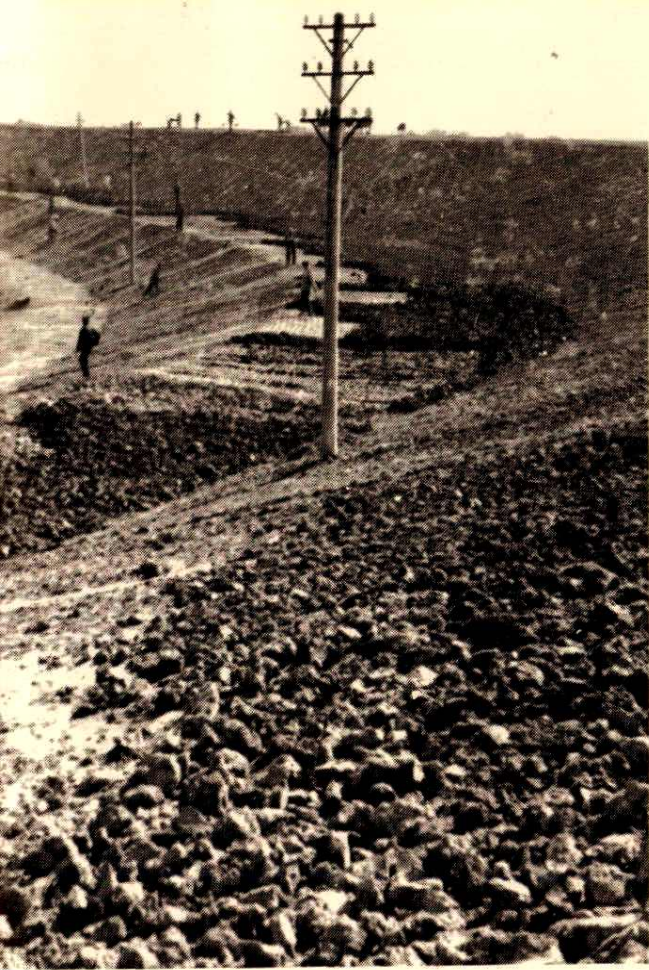
3、蒲圻丰口塘堤段六方混凝土 预制块护坡施工 贺道富摄
