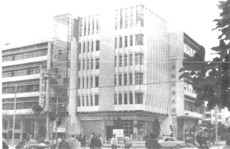
大理市第十一建筑工程公司（银桥乡）承建的大理州劳动服务大楼。
