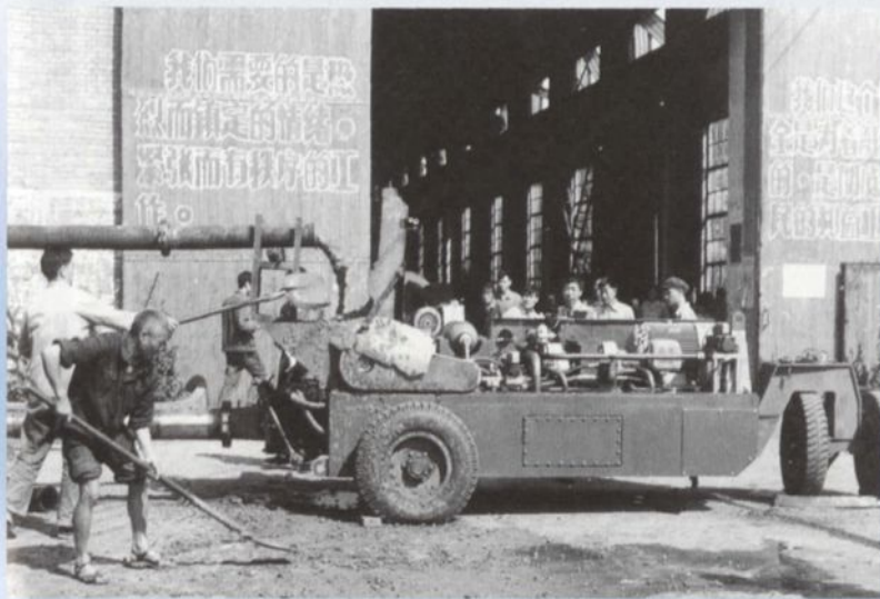
20世纪80年代初期开发制造的30米 3 混凝土输送泵，图为进行泵送试验
