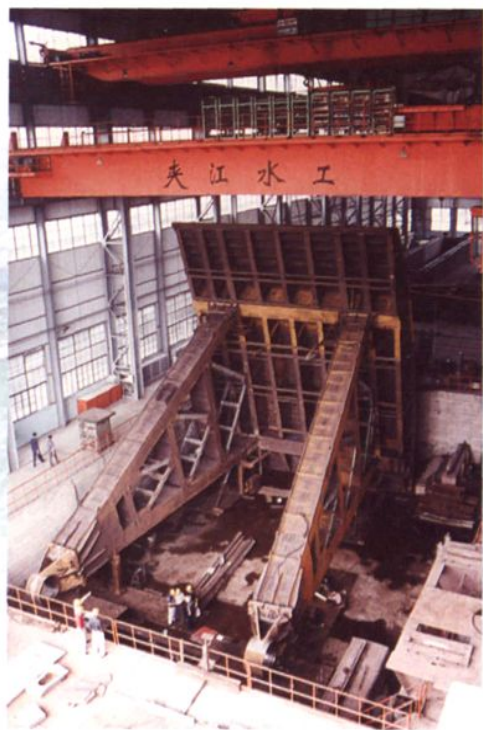
20世纪青海小峡水电站弧门室内拼装
