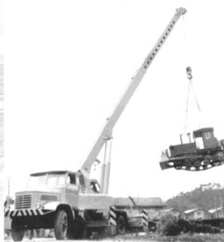
早期开发的新产品，16吨汽车吊 正在试吊
