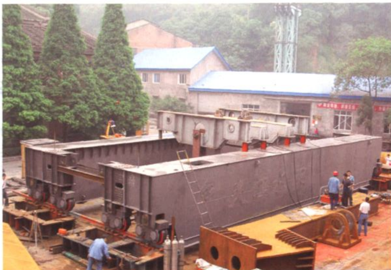
为董箐水电站生产厂房桥机做静负荷试验
