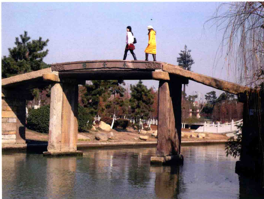
苏州工业园区斜塘永安桥
