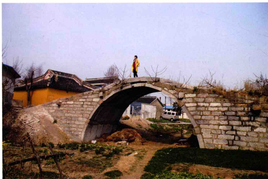
张家港塘桥萧家桥
