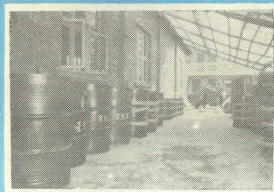
▲ 星光化工厂正在出厂洗油能系列产品
