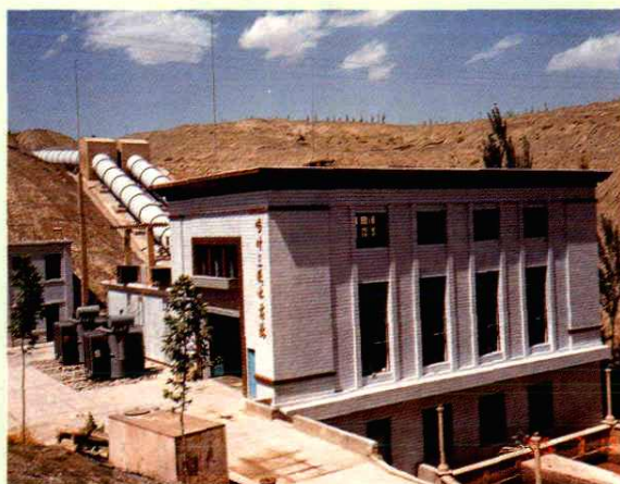
喀什地区三级水电站(装机0.6万千瓦)
