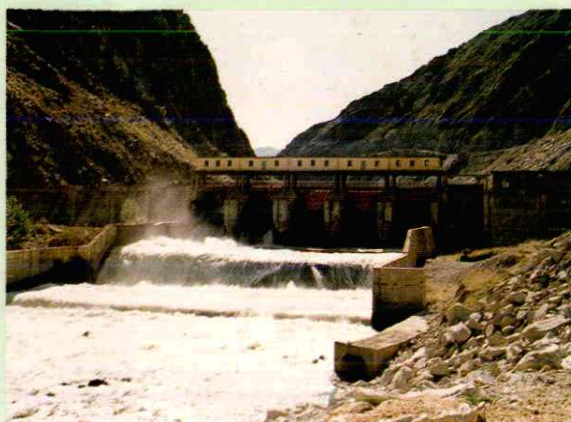
装机容量最大的企业自备水力发电站——新疆有色金属公司可托海矿务局水电站拦河坝(装机1.9万千瓦)
