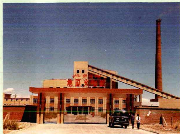
阿勒泰地区北屯电厂(装机1.2万千瓦)
