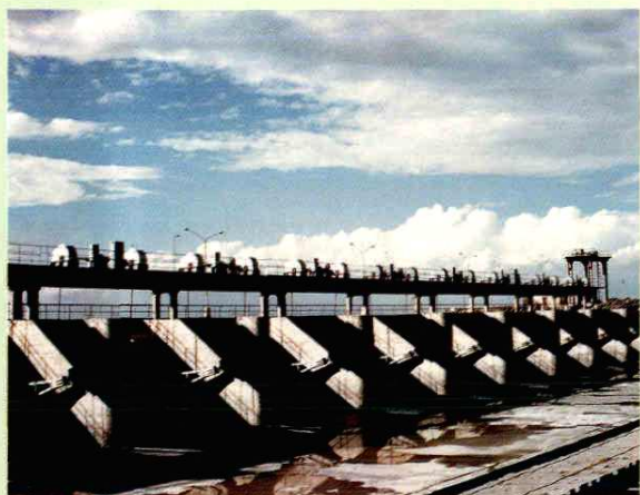
阿克苏地区西大桥水电站冲砂闸(装机1.3万千瓦)
