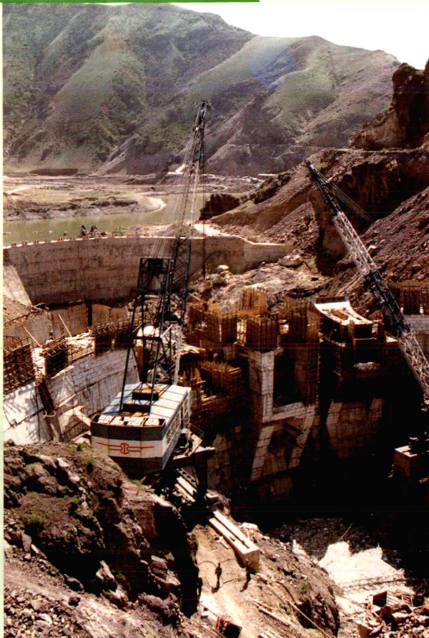
建设中的巴音郭楞蒙古自治州大山水电站(装机 4\times 2 万千瓦)
