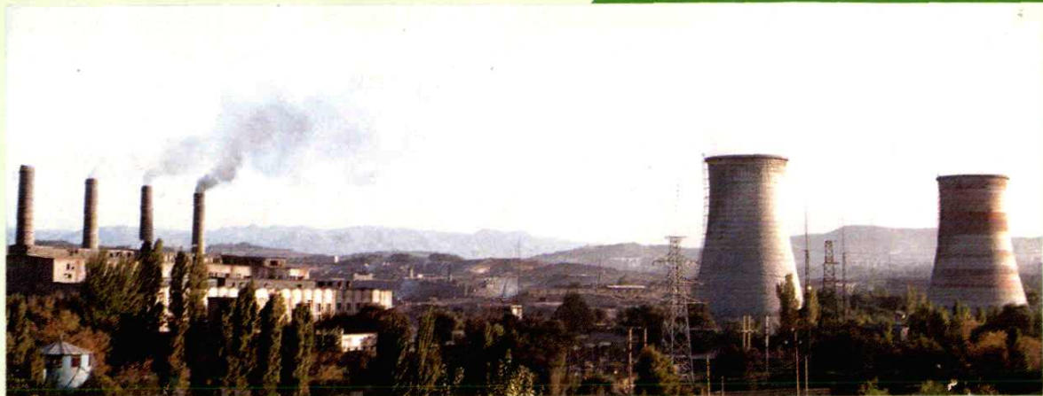
1952年兴建的茅湖梁电厂(装机5.9万千瓦)
