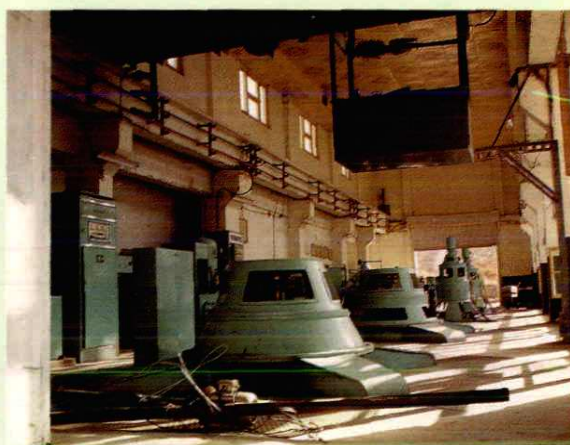
和田地区排孜瓦提水电站(装机0.952万千瓦)
