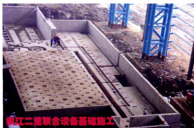
镇江二重联合设备基础施工
