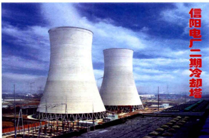
信阳电厂二期冷却塔
