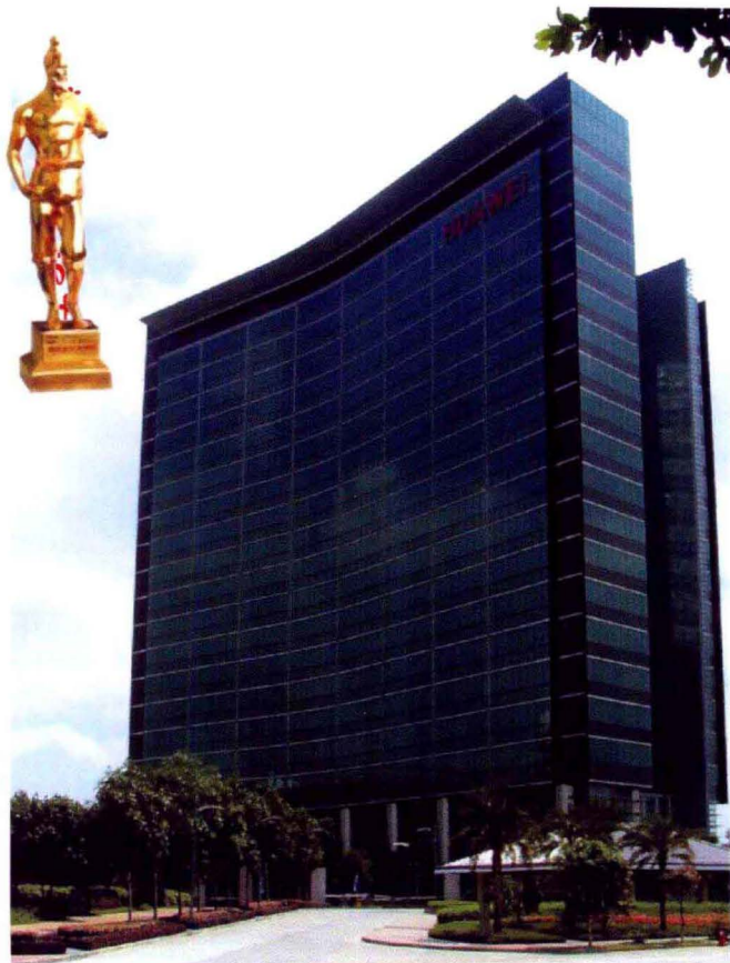
华为研究中心 获鲁班奖 2001年4月22日-2003年9月30日承建
