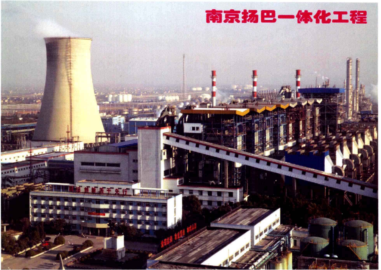
南京扬巴一体化工程 (1995年12月-1997年7月承建)
