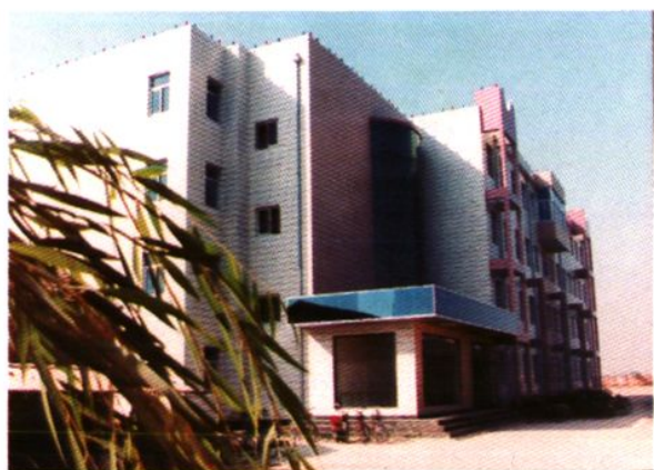
一中科技实验楼
