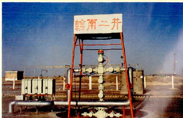
▶ 1989—1990年施工建设的塔里木油田第一口原油生产井—轮南二井
