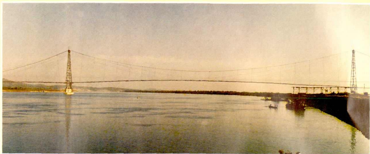
▲ 1983年11月—1984年10月施工建设的湖北汉江跨越管道工程全景
