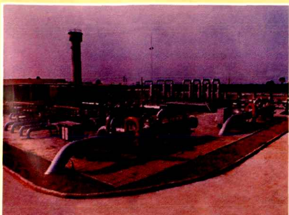
▼ 1975年2月—1976年3月施工建设的成都配气站
