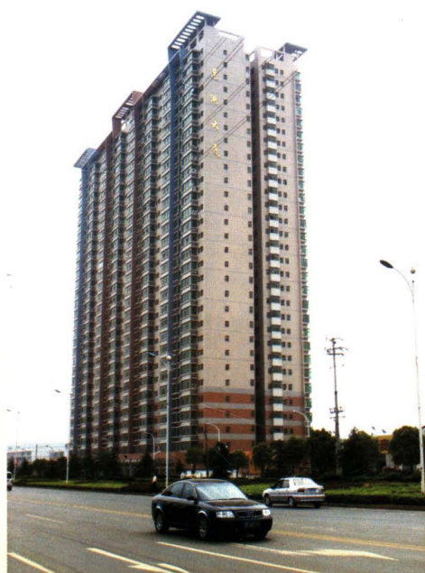
全省第一个高层农民安置小区-莲湖大厦
