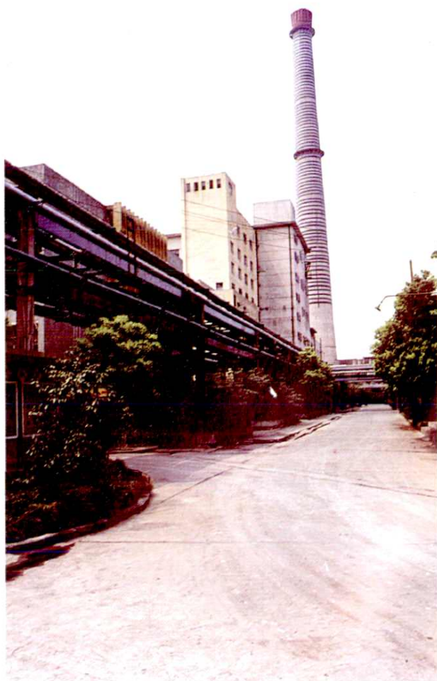
杭州化纤厂120米排毒塔
