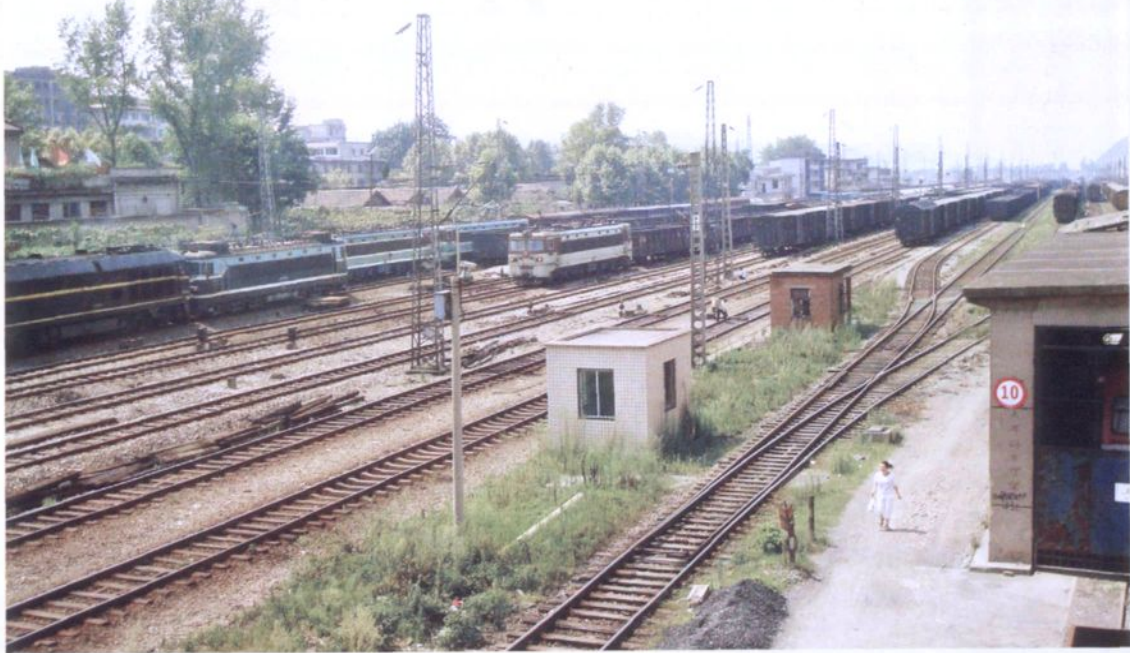
川黔铁路枢纽
