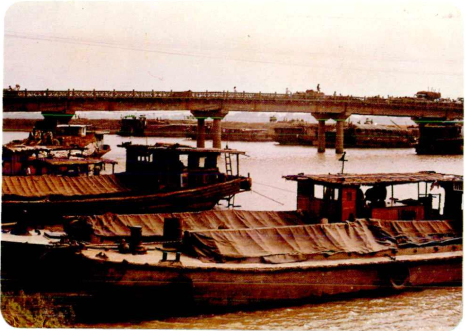
横跨在永安河上的襄安大桥，是军二公路上的重要桥梁之一，图为大桥雄姿。
