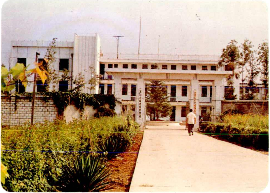
无为大堤，位于长江下游北岸。始建于明永乐三年(公元 1405 年)，建国后进行了全面整修，是保护 巢湖流域七县二市 400 多万亩农田，500 多万人口和淮南铁路安全的重要堤防。图为坐落新河镇上的“无为大堤建设管理局”外景。
