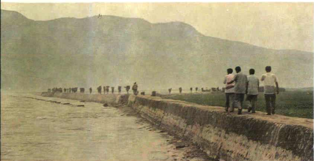
大渡河防洪工程
