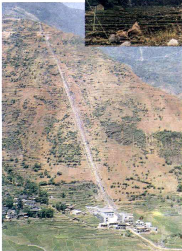
洪福電站——全縣最高水頭電站
