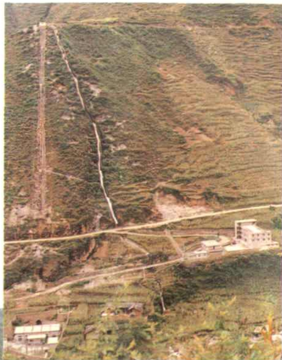
馬烈電站——全縣鄉辦 裝機容量最大電站
