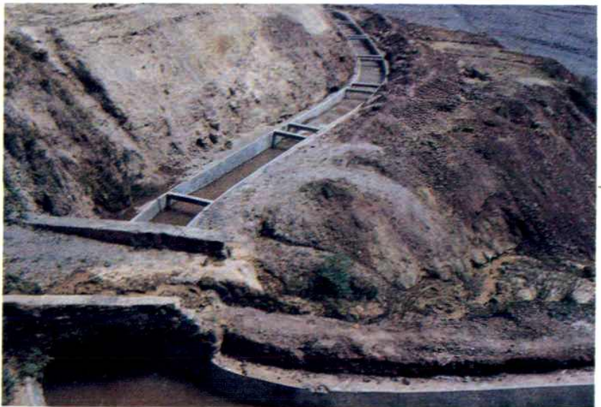
香林堰防滲工程
