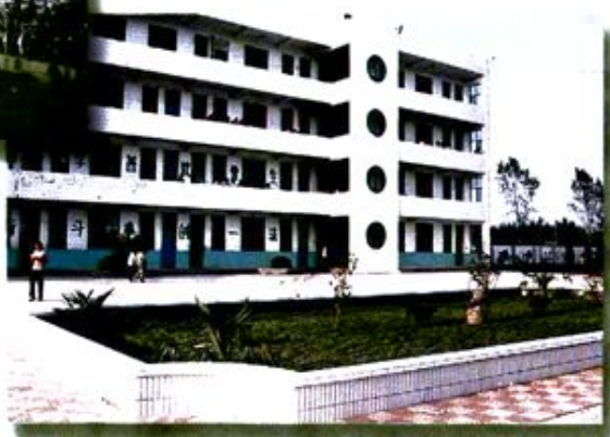
▲ 利用危改资金建设的禅堂中学教学楼。
