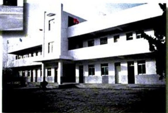
▲ 财政投入危改资金 17.5 万元，建设尤集镇张东湖小学教学楼。
