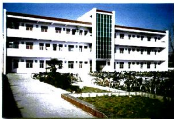
▲ 利用危改资金建设的灵璧四中教学楼,建筑面积(1170m 2 )。
