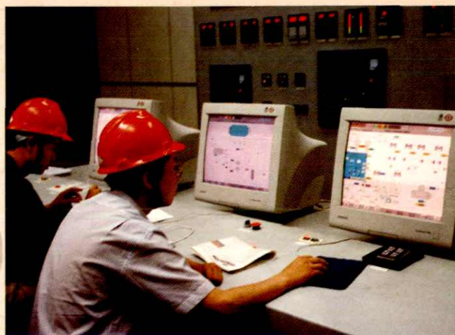
蒙华海电2号机组试运行
