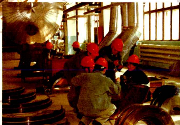
配合电厂汽机检修
