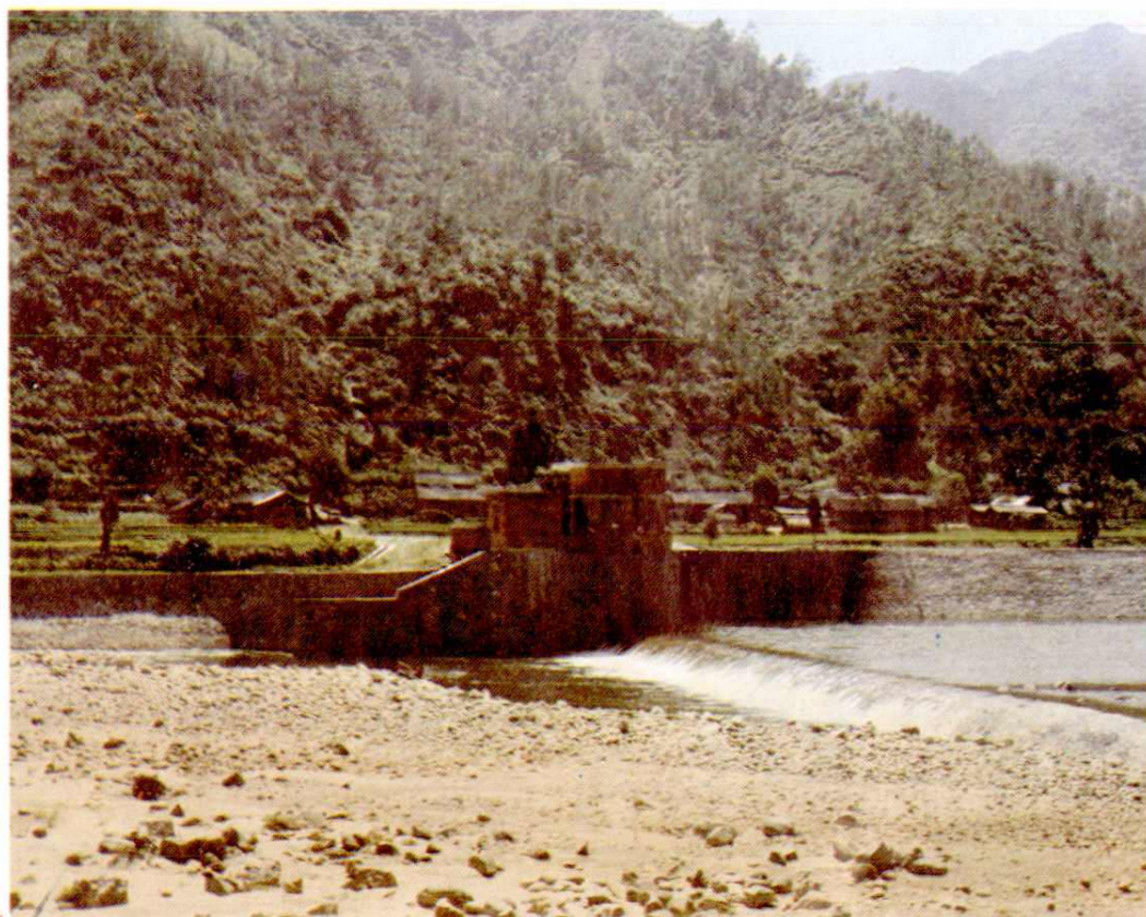
◁ 可灌溉十万八千亩农田的引西工程滚水坝
