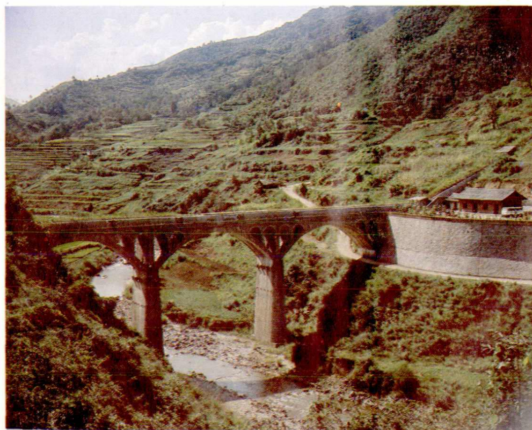
◁ 引西工程八里关渡槽
