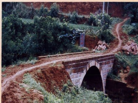
市局（分公司）帮扶并研县金峰乡修建的“金叶桥”
