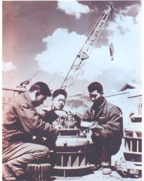
1965年8月，西藏机械修配厂技术人员和工人正在安装自己生产的水轮泵
