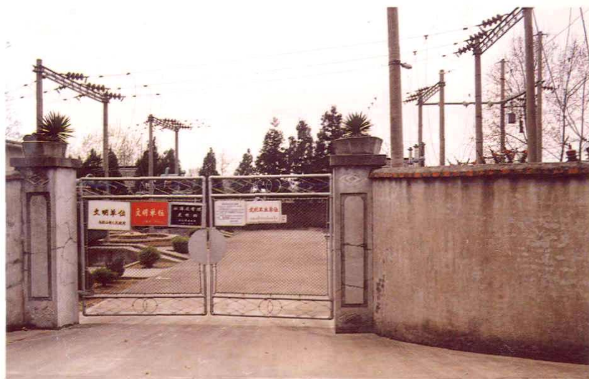
35 千伏省农电标准化变电所——梅山变电所 马鞍山市文明单位
