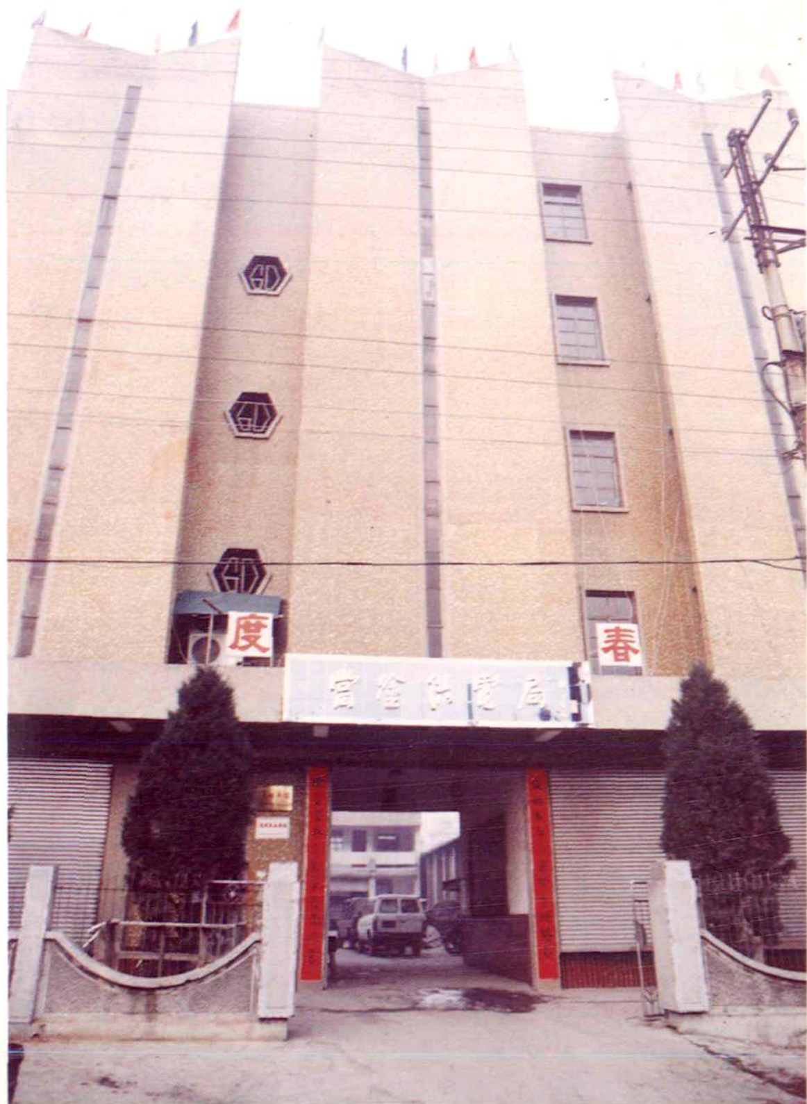
当涂供电大楼
