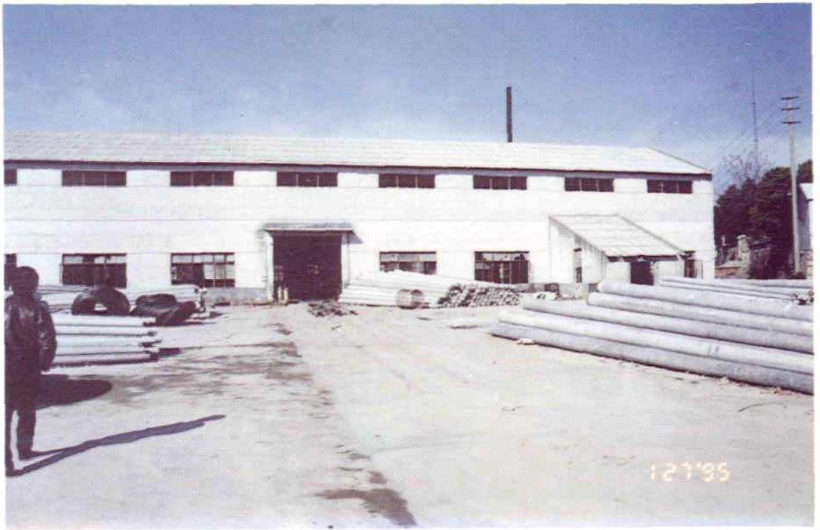
当涂供电局多经企业之二——电力预制厂
