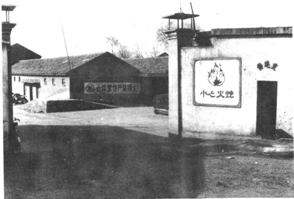
高淳县土产棉麻公司废旧物资仓库
