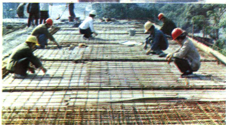
建筑公司施工现场
