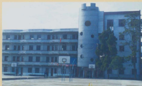
■90年代初修建的办公实验楼
