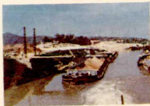
▲钟祥涇河港正在进行磷 矿石装船作业
