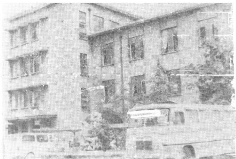
中国人民银行泰安市分行办公楼
