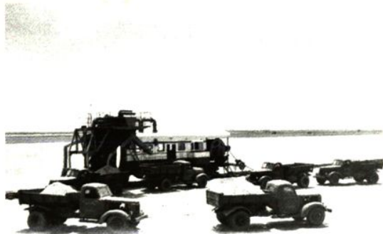
20 世纪 70 年代，吉兰泰盐场轨道式 联合采盐机生产原盐的情景
