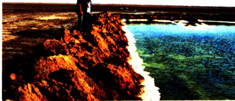
1995年，吉兰泰盐场新打的防洪坝
