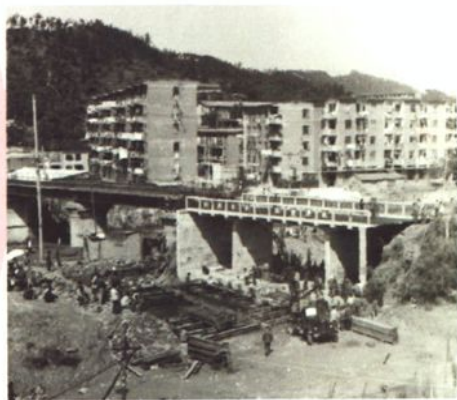
1984年二修在张湾医院箱式框架铁路桥施工现场
