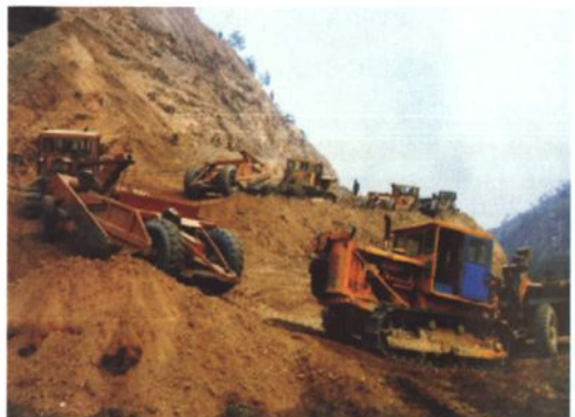
二修在施工工地
