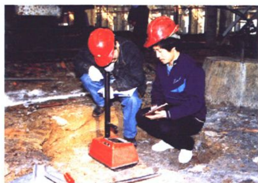
1996年襄樊分公司技术人员在施工现场工作
