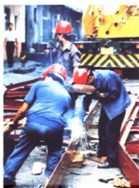
锻造厂大型屋架制作现场
