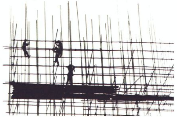
一修1991年现场施工
