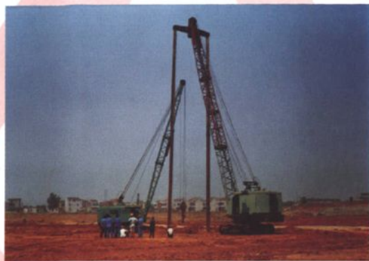
武汉滬口国家粮库工程施工现场
