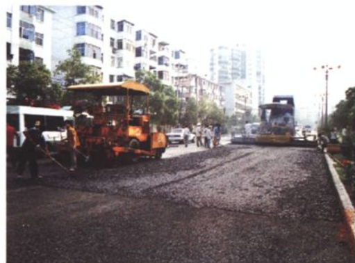
繁忙的公园路施工现场
