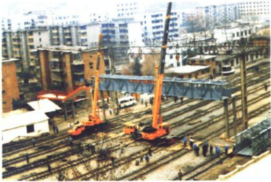
张湾火车站施工现场
