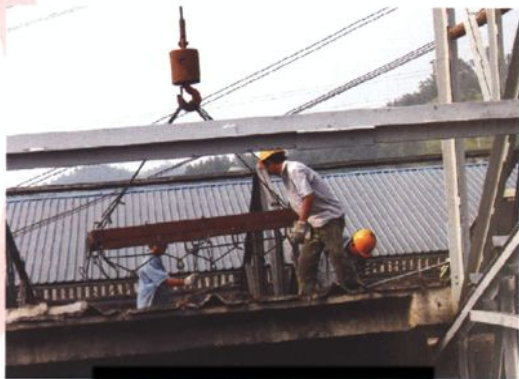
铸造二厂吊装施工现场
