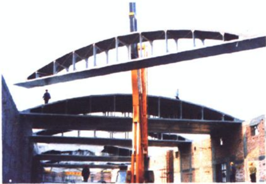
1998年襄樊国家粮库大型拱板吊装现场
