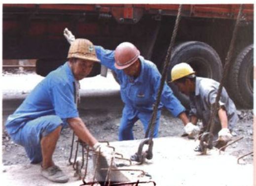
紧张地吊装施工
