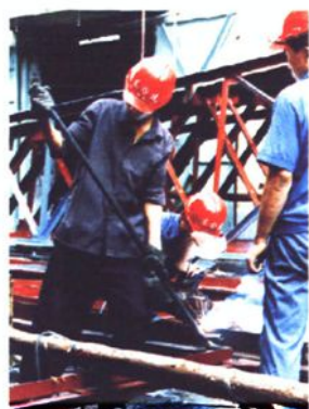
锻造厂厂房屋架施工现场
