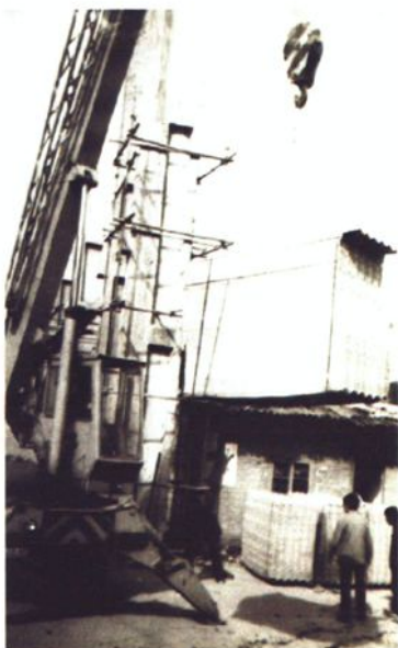
一修在吊装施工用水泥瓦
