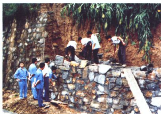
一修抢修塌方挡土墙
