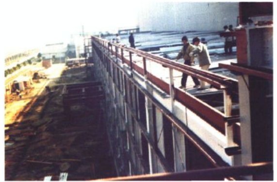
2000年武汉神龙公司厂房屋顶施工现场
