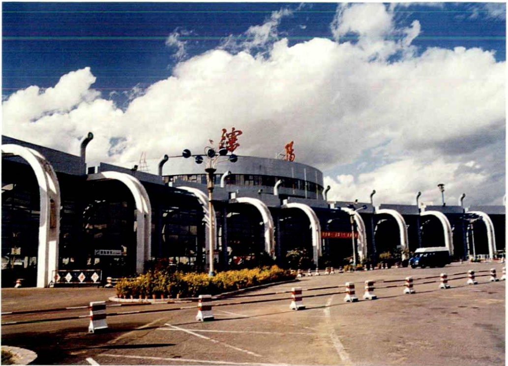
沈阳桃仙机场
