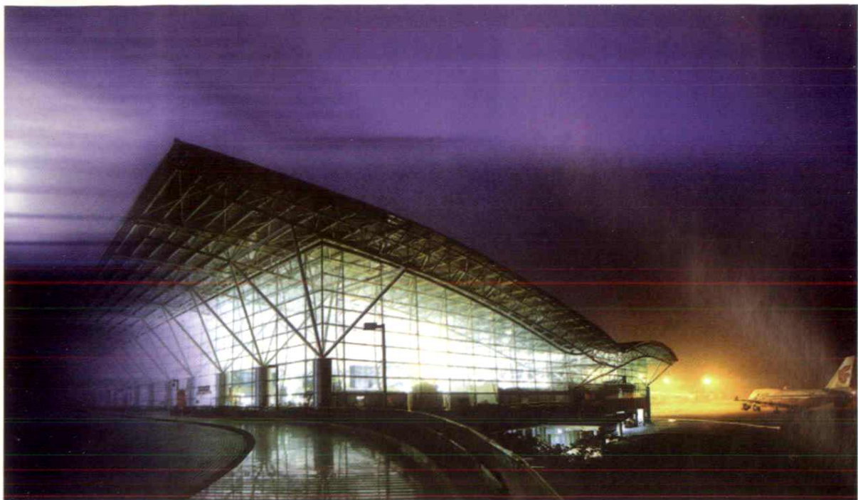
深圳机场(二期工程)
