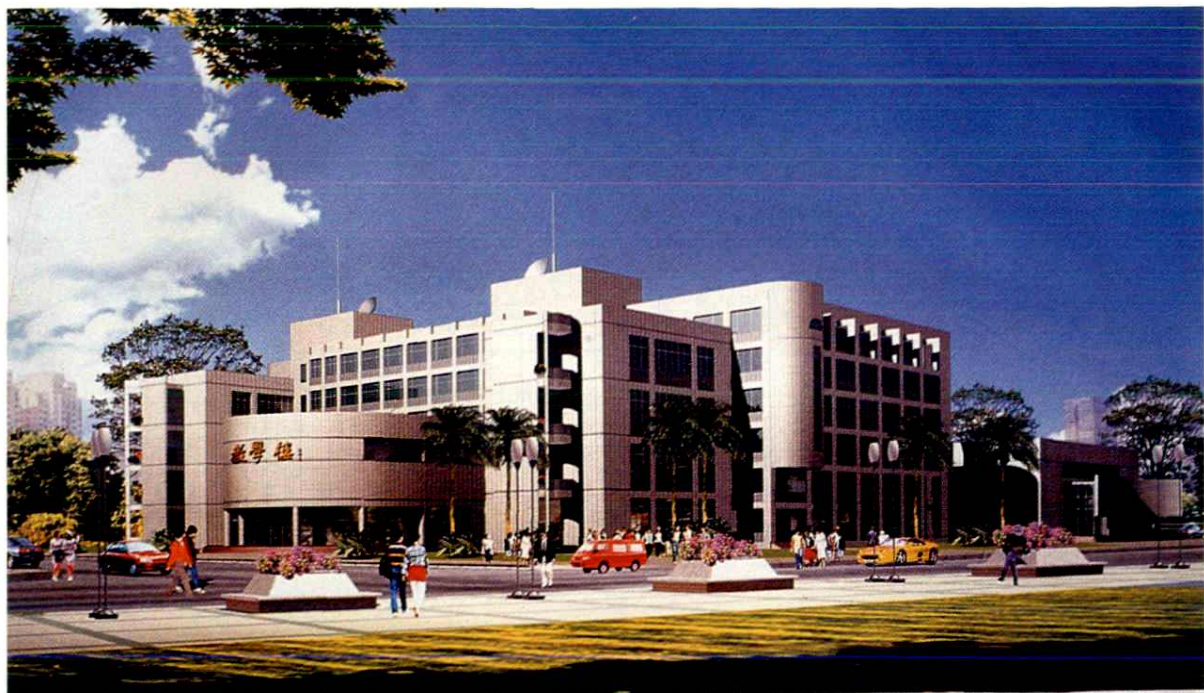
重庆商学院综合楼
