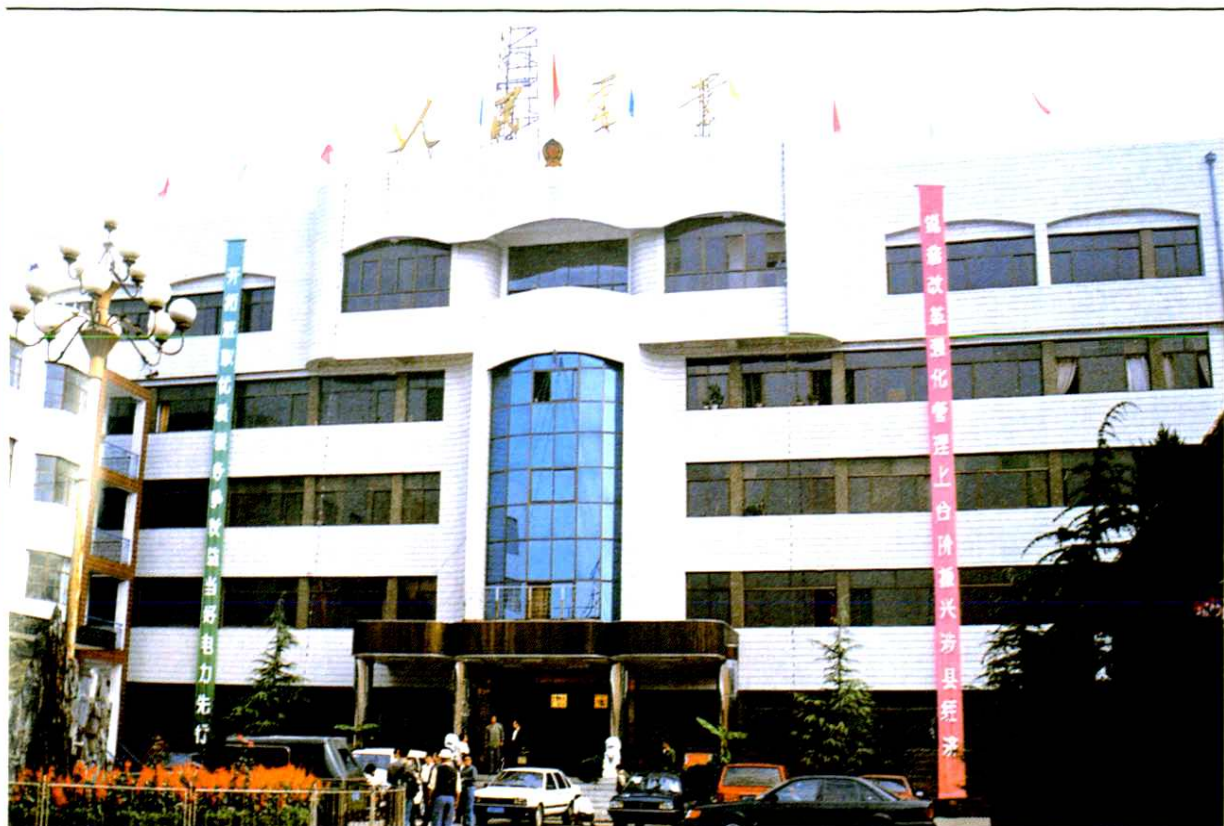
▲涉县电力局仪表调度大楼
