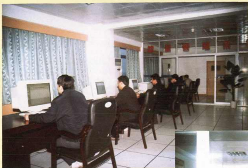
用电能量管理系统
