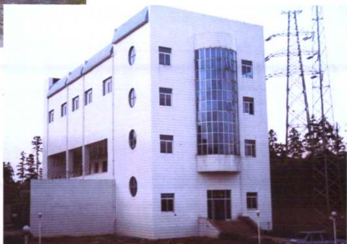
220千伏城北变电站
