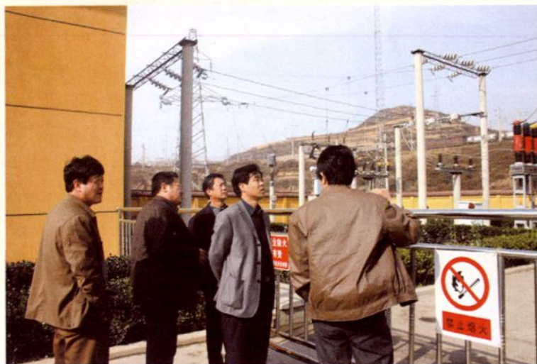
▶ 副县长杨忠华视察煤矿 「双回路电源」建设工程
