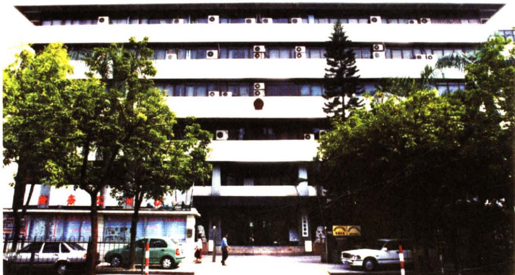
1986年建成的南山区人民检察院南新路办公楼原址。
