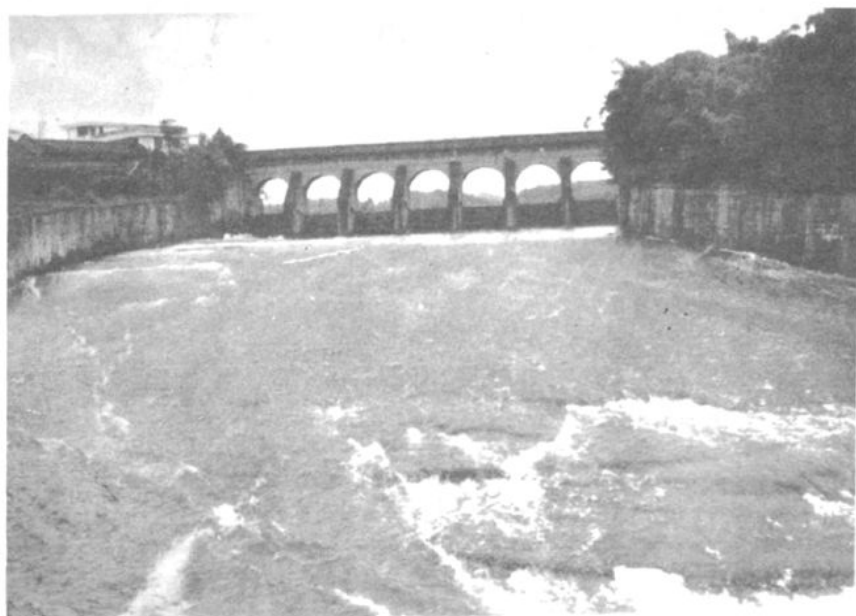
14 跑马滩水库溢洪闸
