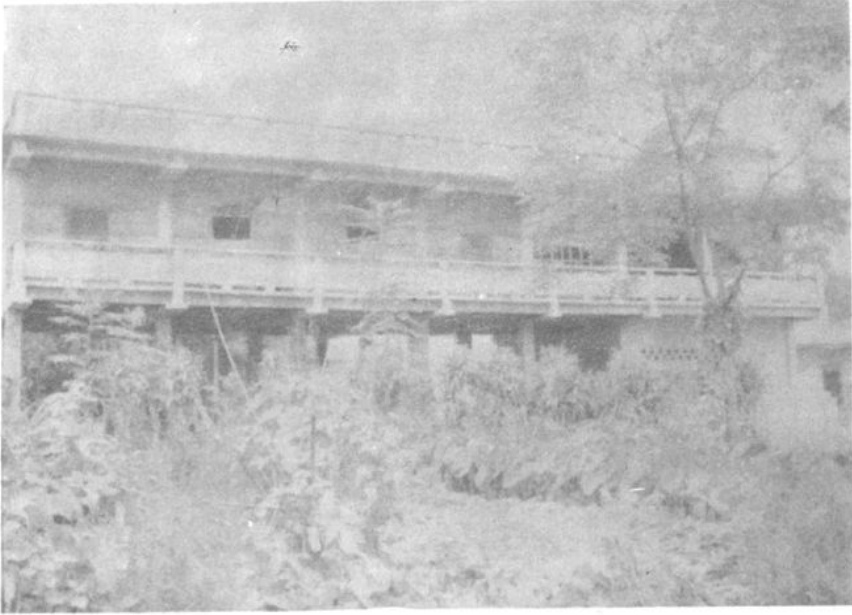
26 永胜乡中脊村三组修建的框架式防洪救生台
