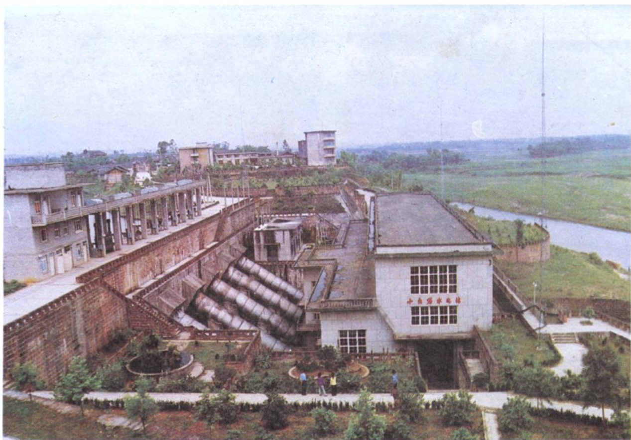
小白塔水电站厂房
