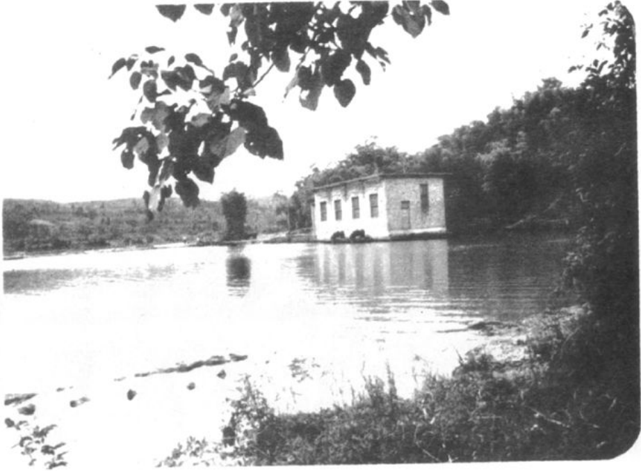
17 龙凤前池一级电力提灌站
