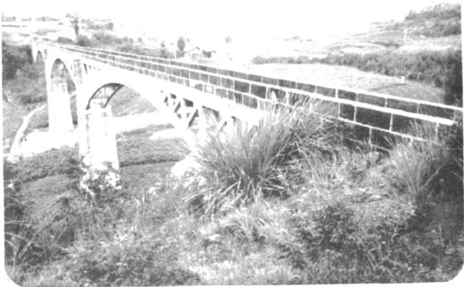
18 麻子滩水库电力提灌站渠道渡槽
