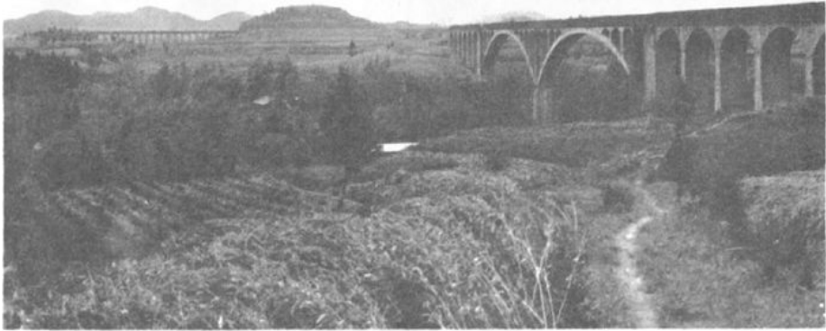
15 新生水库中渠吊石岩渡槽
