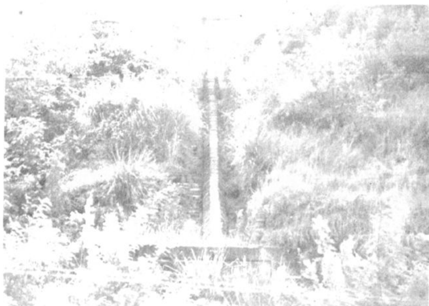
19 金马二水磨电灌站石质水管
