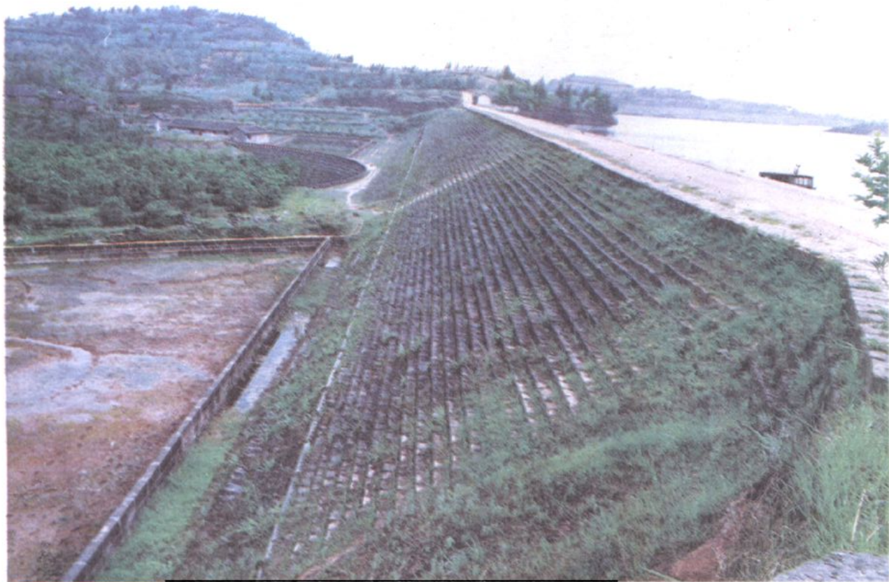
麻子滩中型水库大坝工程
