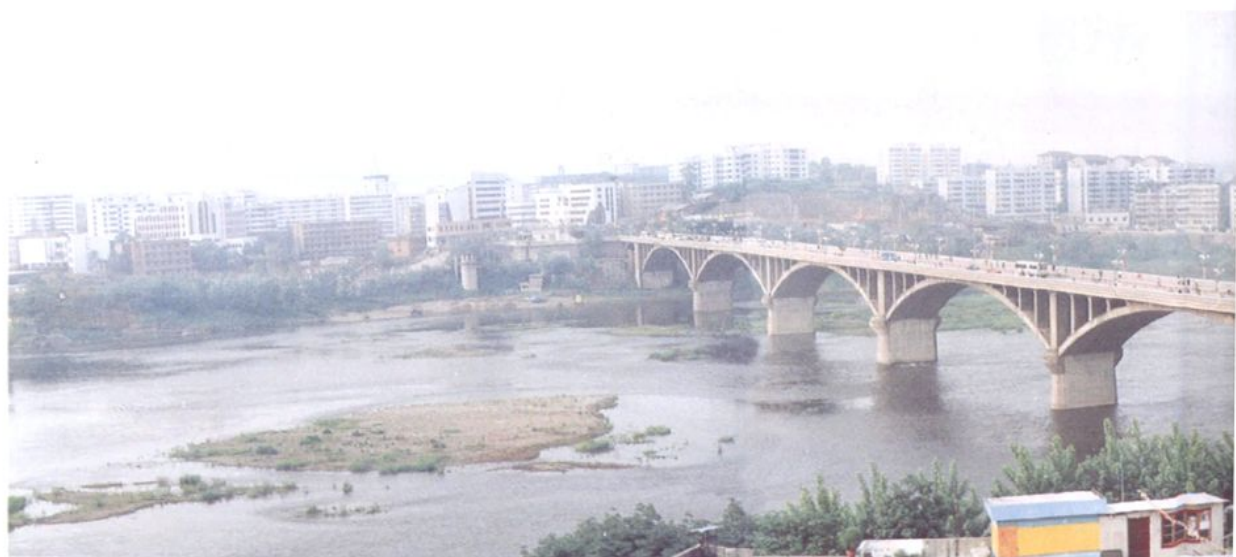
● 内江西林大桥。
