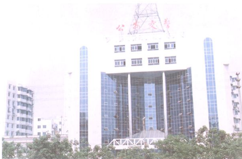
● 新建成的支队综合大楼。
