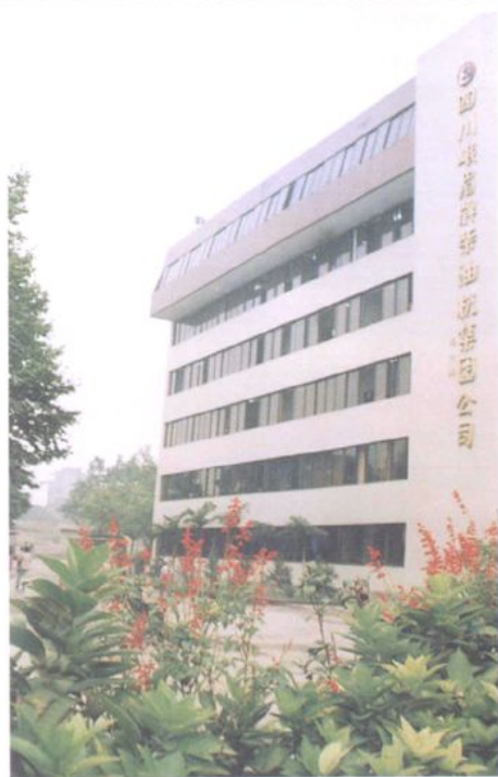
● 公司综合大楼。
