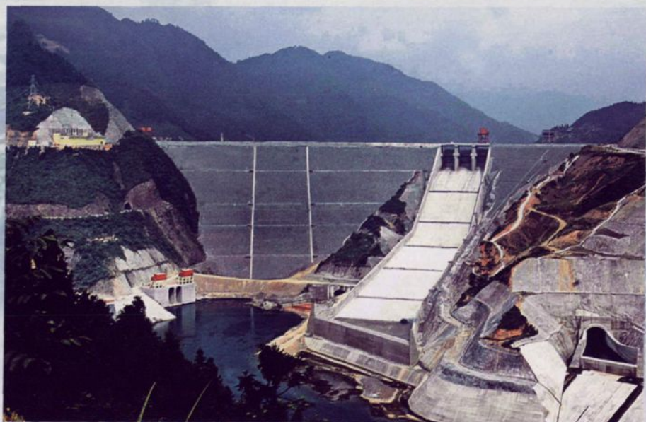
贵州三板 溪水电站
