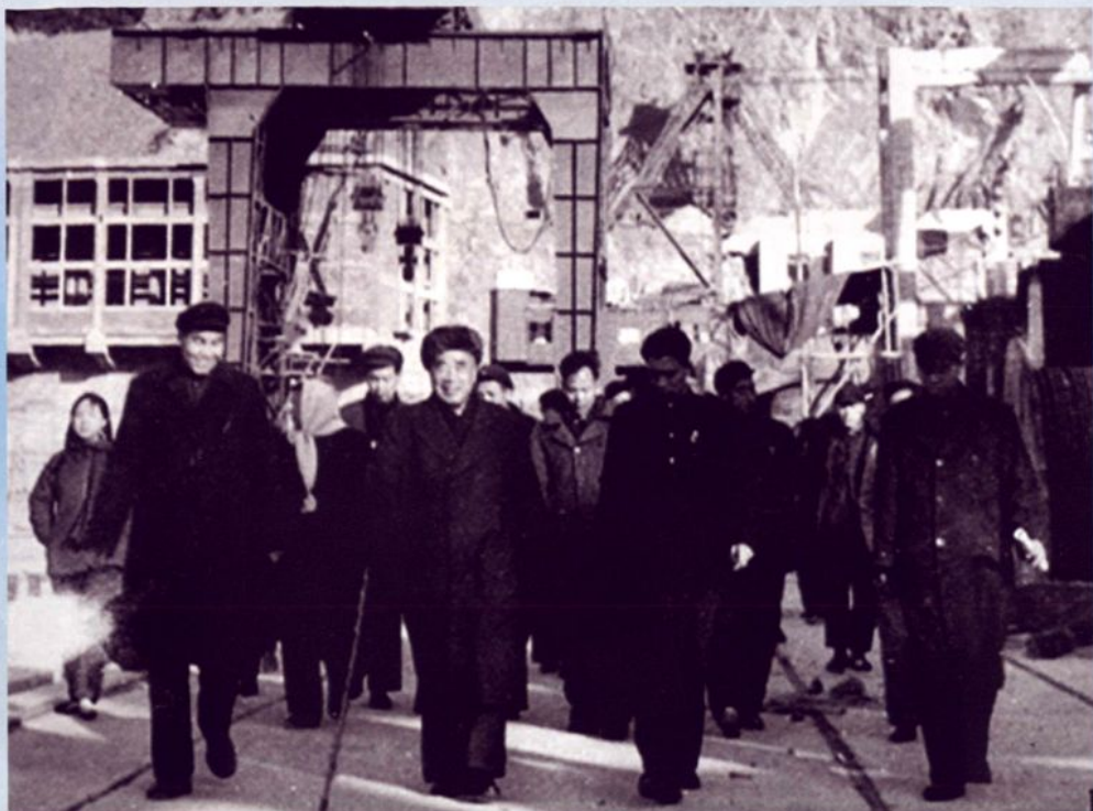
1961年1月31日，中共中央副主席、全国人大常委会委员长朱德视察工程局承建的新安江水电站
