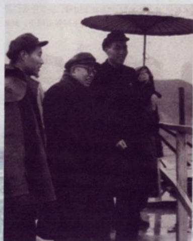
1960年1月21日，国务院副总理谭震林到新安江水电站工地视察
