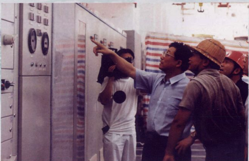
2000年6月27日， 浙江省省长柴松岳 视察浙江温州珊溪水利 工程
