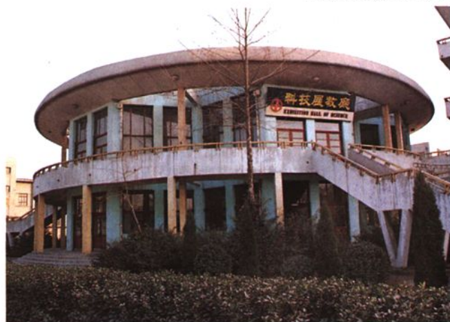
淄博市科技馆展教厅
