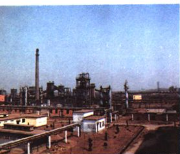
焦化煤气工程厂区一角
