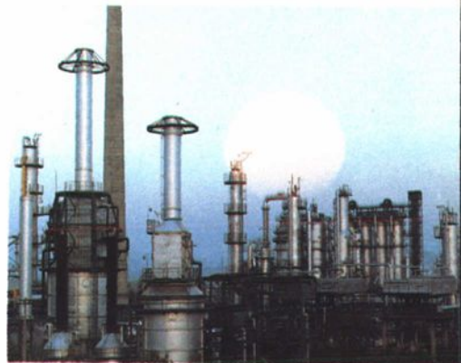
齐鲁石化公司炼油装置
