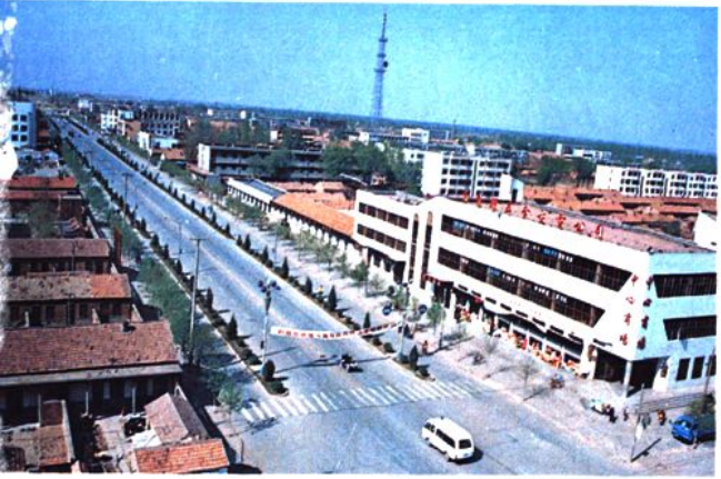
高青县城区内高级城市道路
