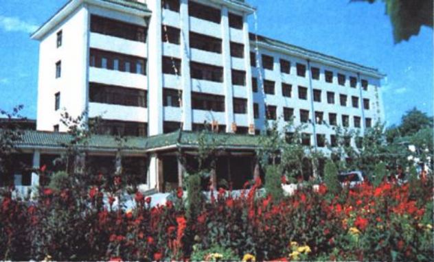
淄博中医院门诊楼
