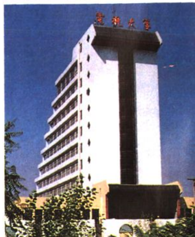
淄博电大教学楼
