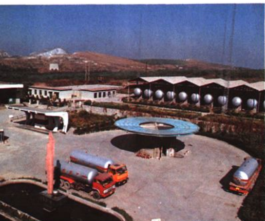
淄博市煤气公司湖田贮气厂
