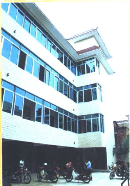
迁远财政所新落成的办公大楼。
