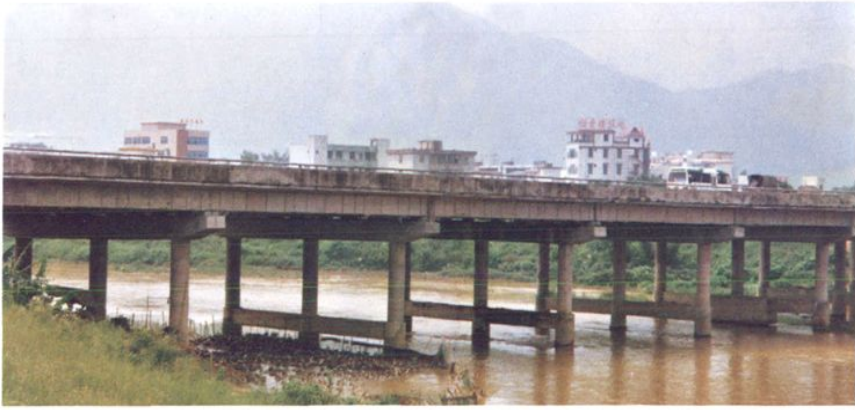
▲清四一级公路三坑大桥
