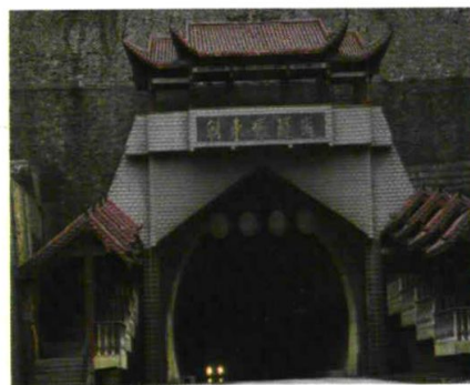
318国道朝东岩隧洞（2003年摄）
