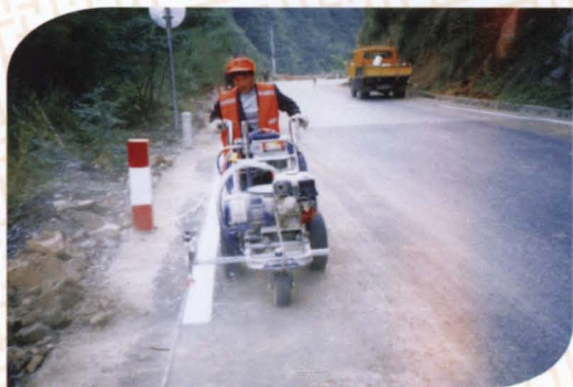
养路工正在给公路画边线。
