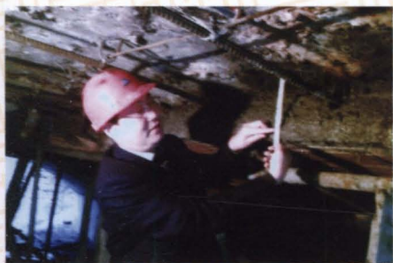
工程技术人员孙光文对危桥加固工程进行检测的情景。
