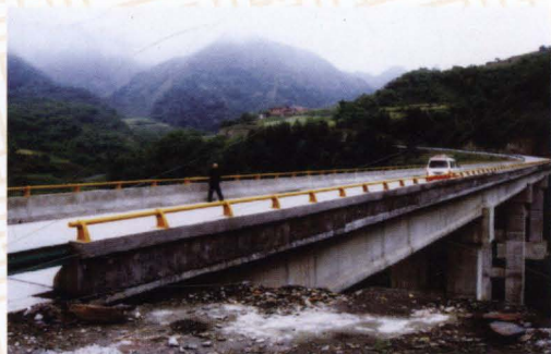
2009年建成的赶集沟大桥。
