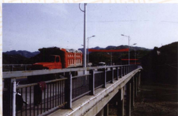
2009年建成的堵河二桥。
