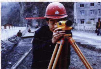
2009年，公路局总工程师柏峰正在测量危桥修复情景。
