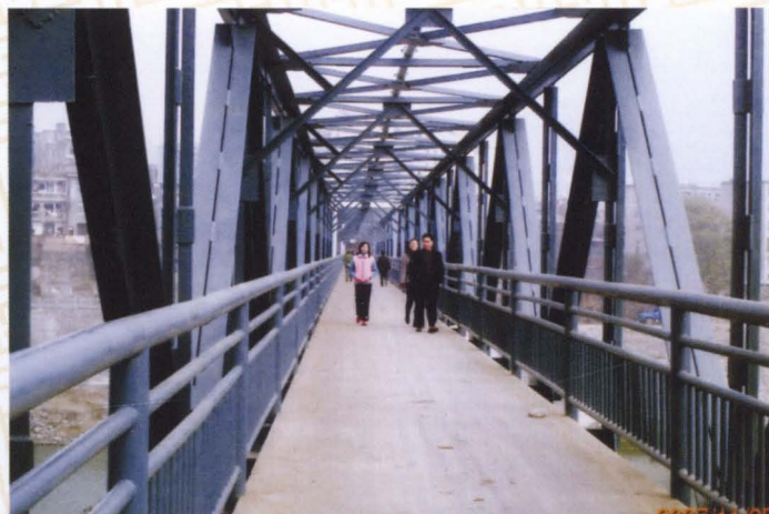
城关镇南门人行铁桥。
