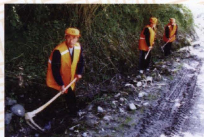
新码头管理站养路工仍养护库区淹没区的砂石路。
